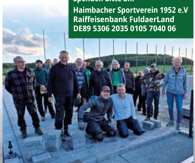
Unsere AH-Fußballer beim Unterstützen der Pflasterarbeiten.
